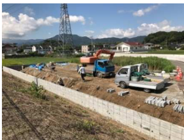
↑農地(田んぼ)だった場所を建築用地に変更する為、造成を行っているところです。農地に建てる場合はこのような作業が必要になります。
