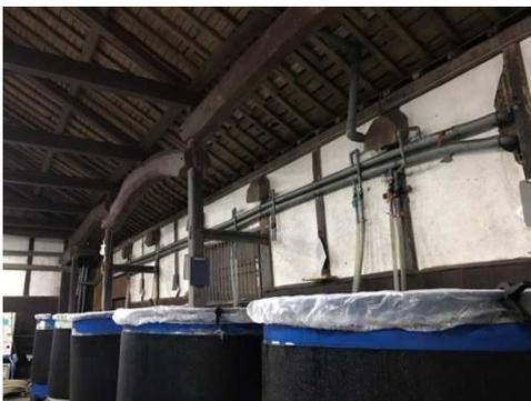
合掌造りの陸梁、桁との取り合いは、「折置組」です。敷桁の梁部分に注目!
