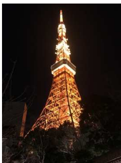
↑今も色あせない、日本のシンボル『東京タワー』 トラス構造で建てられ、当時建てられた塔では一番高い建物でした。
